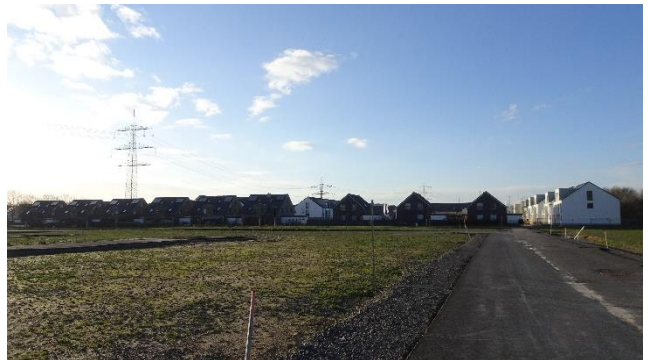
Abb. 8: Blick auf das nördlich gelegene Gebiet des Bebauungsplan 71B mit bereits realisierter Bebauung im Hintergrund (ISR 2020)
