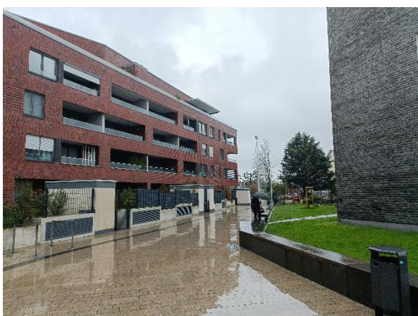
Abb. 11: Angrenzende Wohnbebauung nordöstlich des Plangebietes (ISR 2024)
