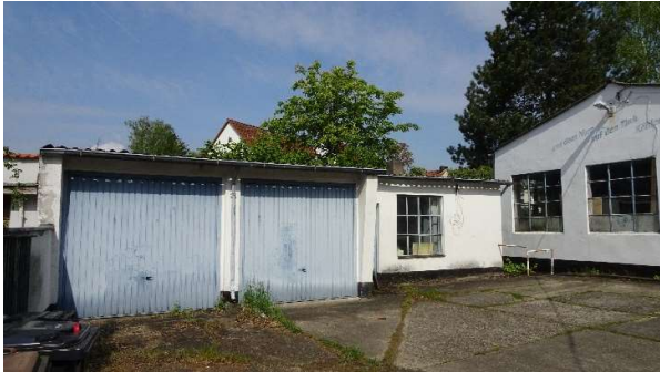
Abb. 5: Garagen und Lagergebäude im südwestlichen Plangebiet (ISR 2021)
