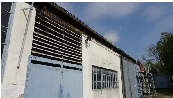
Abb. 9: offener Bereich in der Fassade der Lagerhalle im nordöstlichen Plangebiet (ISR 2021)
